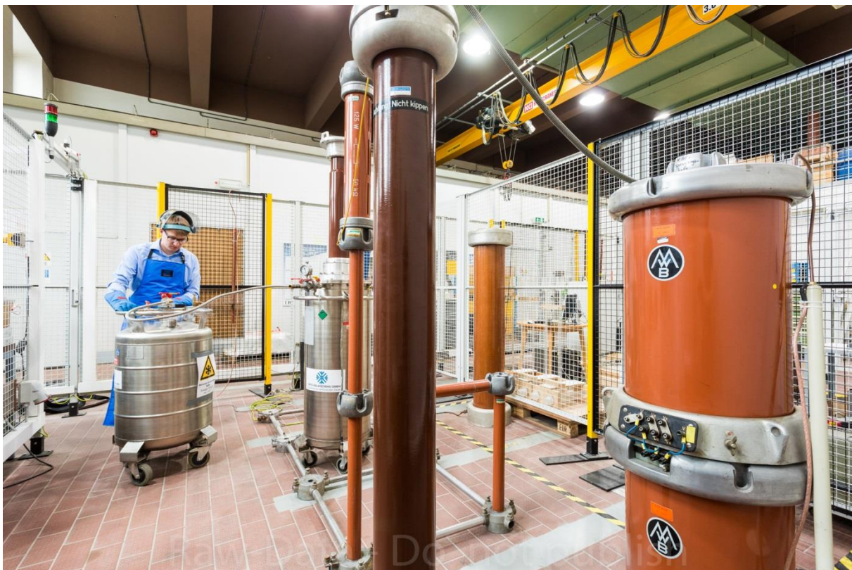
Abbildung 1: Zentrum für Netzintegration und Speichertechnologien
